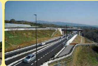
東駿河湾環状道路(三島市) 市街地の渋滞緩和と伊豆方面へのアクセス向上のために
