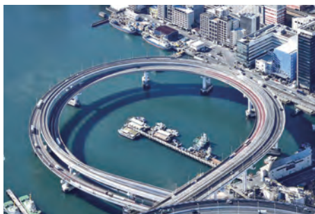
▲道路建設や整備
