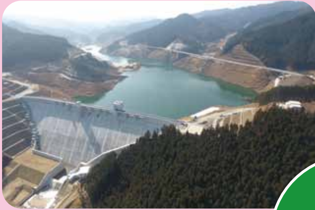
伊良原ダム（みやこ町）
