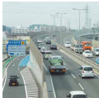
橋や道路の整備
