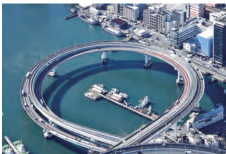
▲道路建設や整備 提供 東京都
